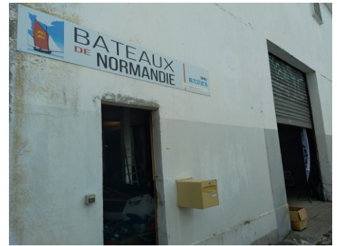
Un chantier naval en rénovation
